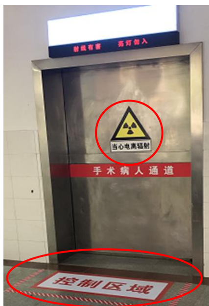
图 4-2 本项目当心电离辐射警示标志及地面警戒线
